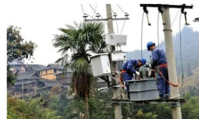
乡村线杆油浸变压器安装
