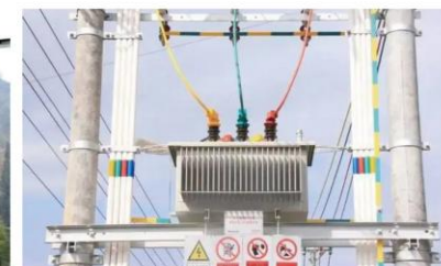
公路线杆油浸变压器安装
